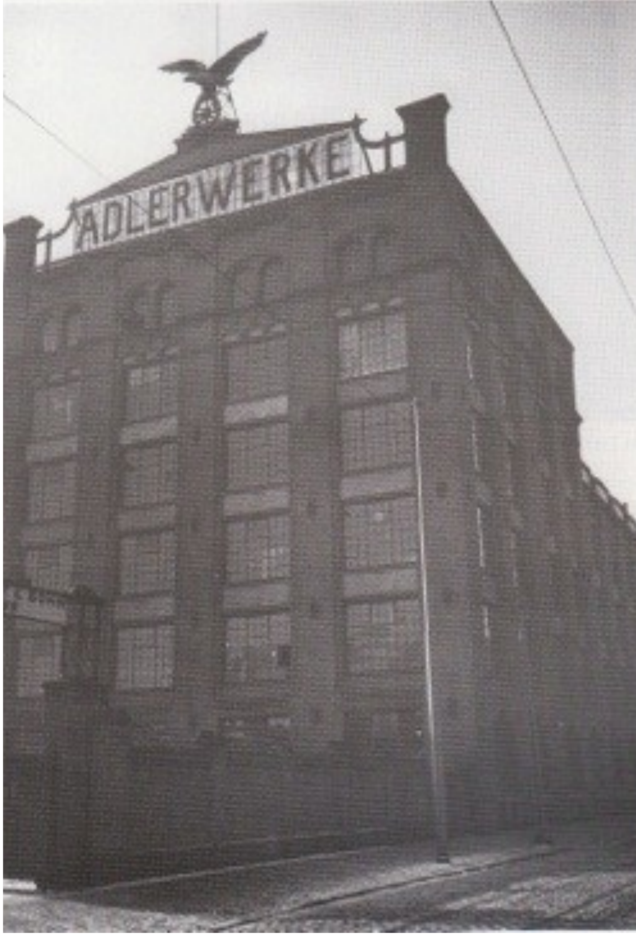
Frontfassade der Adlerwerke in der Kleyerstr. ca. 1940
